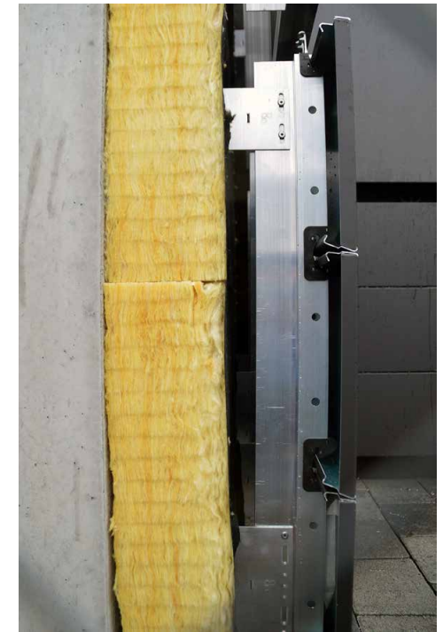
Ein Beispiel für eine demontable und recyclingfähige Fassade:
